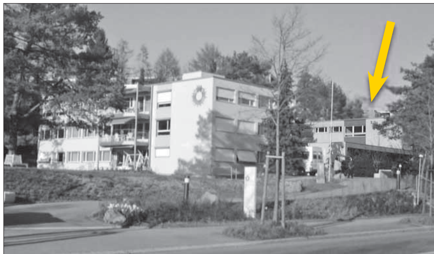
Wohnheim Frankental, Westtrakt
