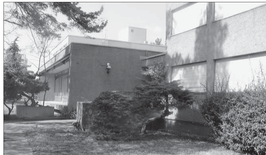
Seitenansicht Osttrakt mit Haupteingang
