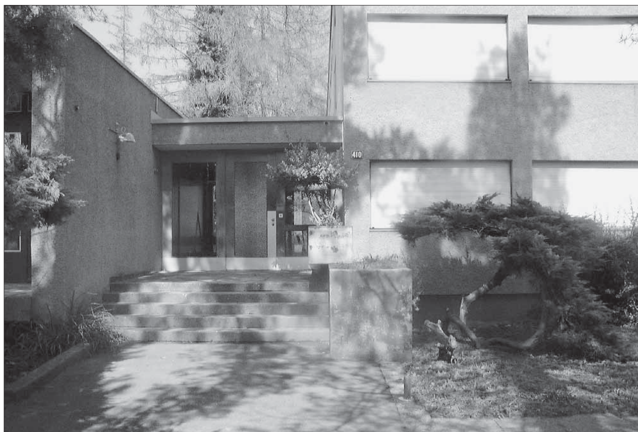
Haupteingang Projekt Ost, Limmattalstrasse 410
