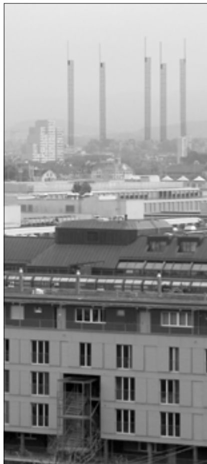
Das Baugerüst zeigt, wie gewaltig das Hochhaus die Sicht von Höngg Richtung Innenstadt verändern wird.
