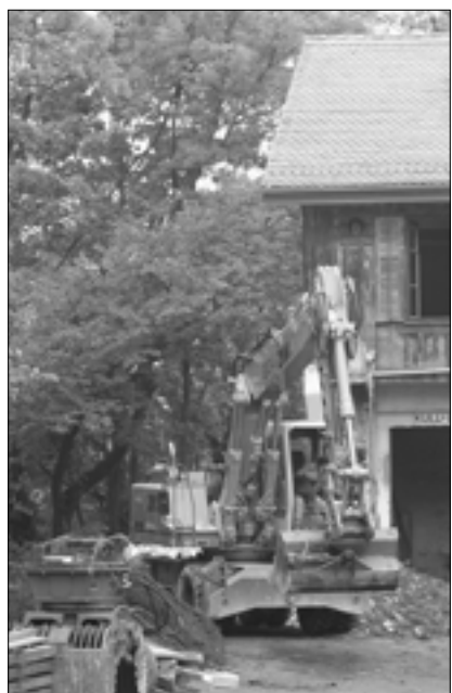
Die Bagger machen den Weg frei für den neuen Limmatuferweg. Foto: Sarah Sidler
