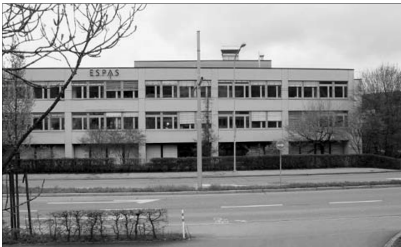
Auf dem Dach des Gebäudes an der Naglerwiesenstrasse 4 will Sunrise drei neue Mobilfunkantennen anbringen. (scs)
