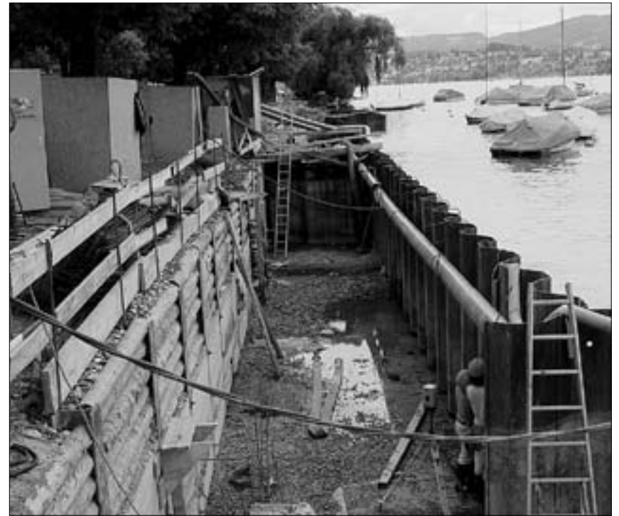
Um das neue Fundament einzubauen, musste die Baugrube aufwändig trocken gelegt werden. (zvg)
