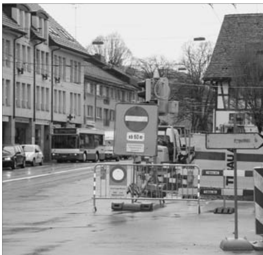
Die Limmattalstrasse ist ab dem Meierhofplatz, stadteinwärts gesperrt. Dies wirkt sich negativ auf das umliegende Gewerbe aus. (Foto: Sarah Sidler)
