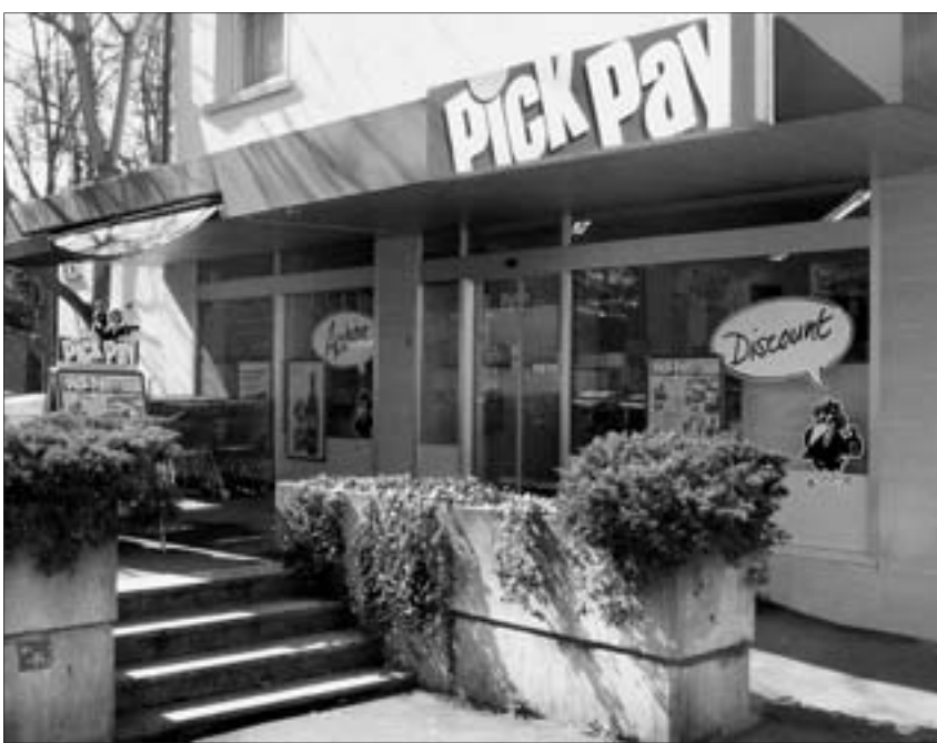
Durch diese Türe verschaffte sich die Diebe Zugang.
