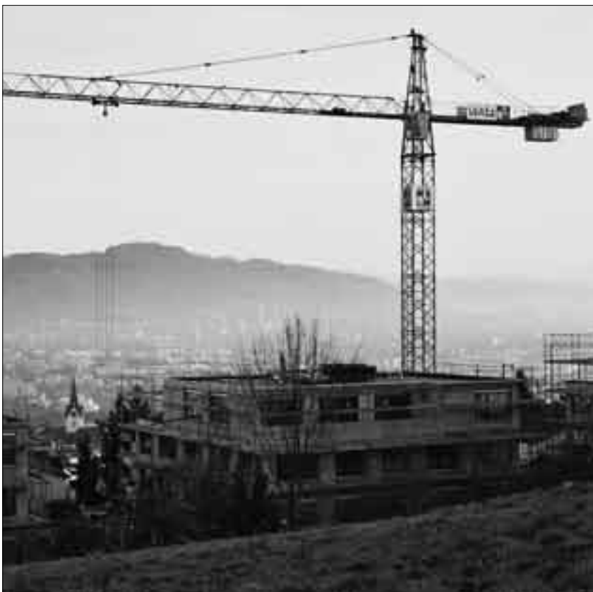
Blick über die Baustelle der Siedlung Kappenbühl. (Foto: Béatrice Christen)
