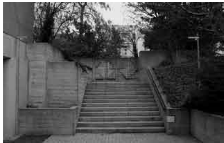
Der unterirdische Anbau kommt hinter diese Treppe zu liegen. Diese wird um die Zufahrt zu erleichtern nach links verschoben. (Foto: Sarah Sidler)
