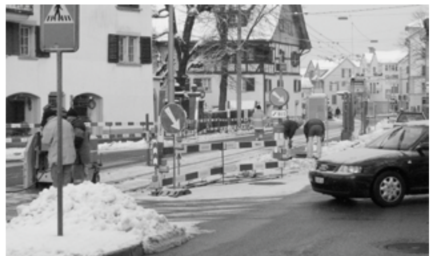
Am Dienstag begannen die Vorarbeiten für die Gleiserneuerung.
