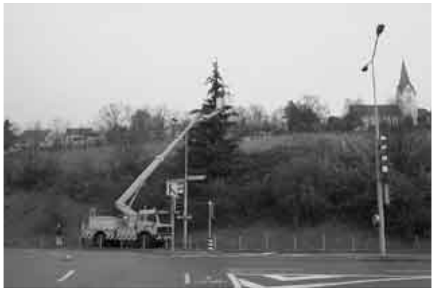
Peter Ruckstuhl von Marolf Elektrik gemeinsam mit dem EWZ-Monteur 20 Meter ab Boden...
