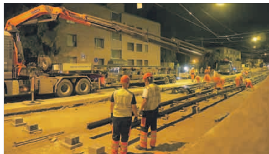
Verlegen der neuen Geleise in der Nacht auf letzten Sonntag.
