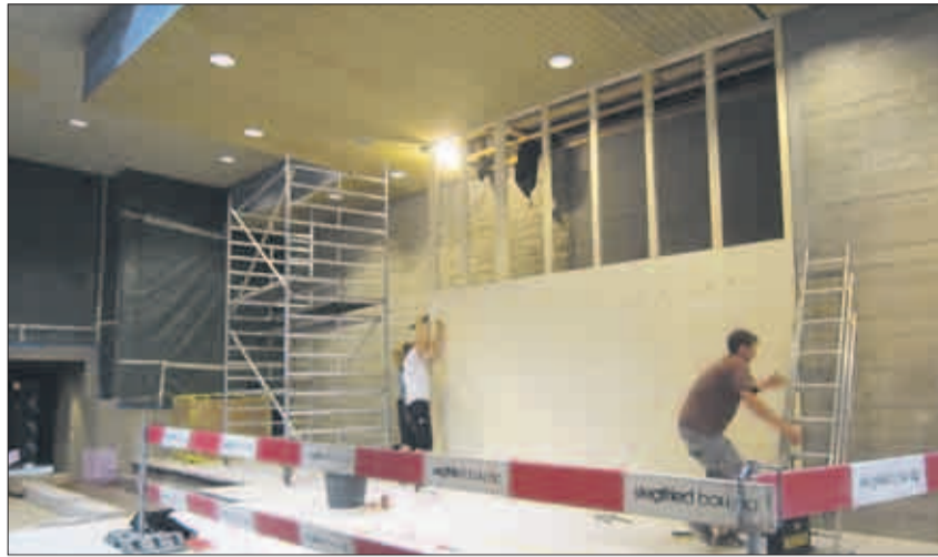
In der Kirche Heilig Geist wird umgebaut.
