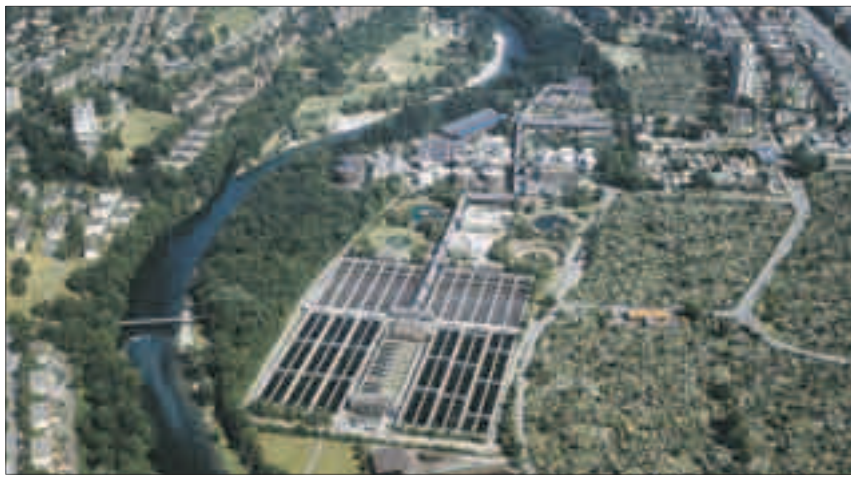
Die Kläranlage Werdhölzli gewann einen Preis.
