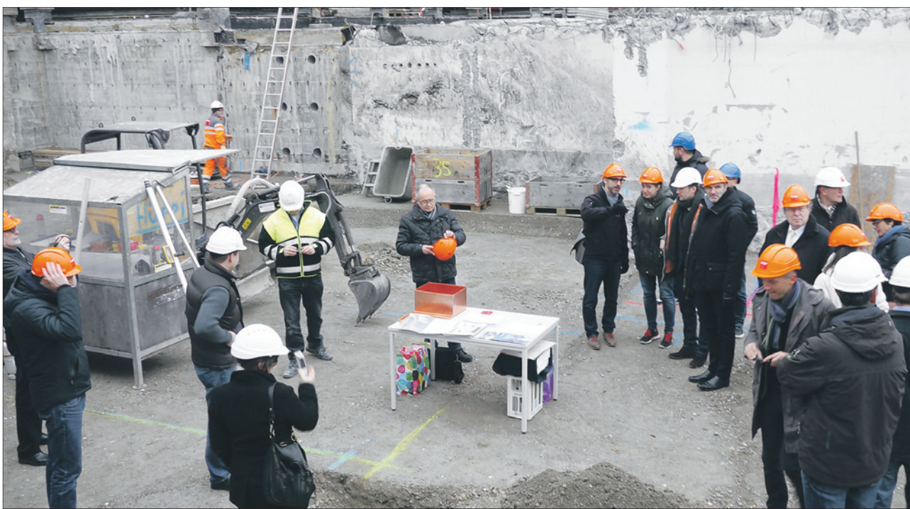
Alles ist bereit für die Grundsteinlegung in der Baugrube des neuen «Riedhof»-Traktes.
